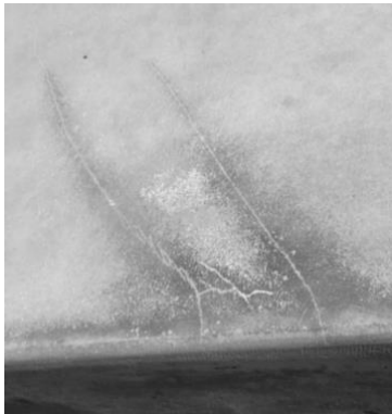
Des fissures non structurales peuvent apparaître en raison de l'âge et de l'exposition aux intempéries, mais elles n'affectent pas l'usage du mobilier.
